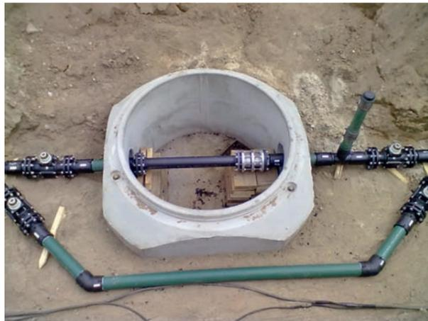
Abb. 1: Teststrecke zur Überwachung von Inkrustationen im Unterdrucksystem. Foto: HAMBURG WASSER
