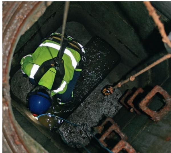
Abb. 1: Einrichtung einer Durchflussmessung für die Abflusssteuerung in Reutlingen. Foto: ISWA, Universität Stuttgart, 2015
