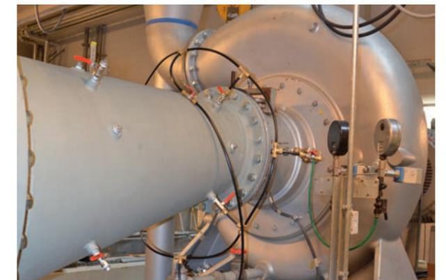
Abb. 2: Pumpe im Hauptpumpwerk Wilmersdorf, Berlin – neuralgischer Bestandteil des Abwassersystems. Foto: FG Fluidsystemdynamik, TU Berlin
