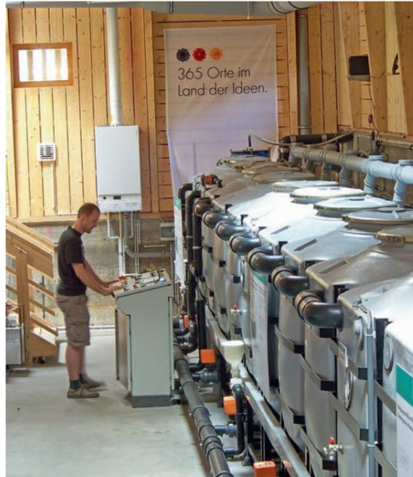
Abb. 2: Grauwasserrecyclinganlage der Wohnanlage „Block 6“ in Berlin. Foto: E. Nolde/Flickr
