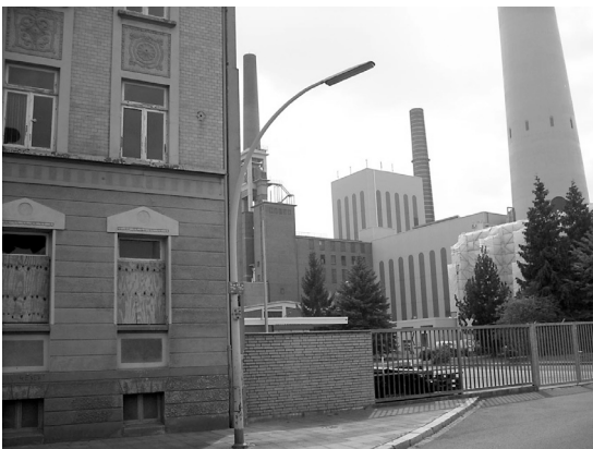
Nach wie vor kein attraktiver Wohnstandort: Leer stehendes Gründerzeithaus in der Nachbarschaft eines Kraftwerkes. Foto: Gregor Jekel
