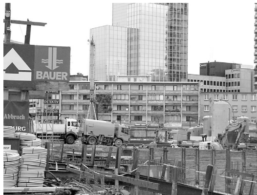
Wohnen an der Großbaustelle für ein innerstädtisches Einkaufszentrum.
