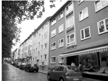
Sanierte 50er-Jahre-Bauten am Entenanger. Foto: Franciska Frölich von Bodelschwingh
