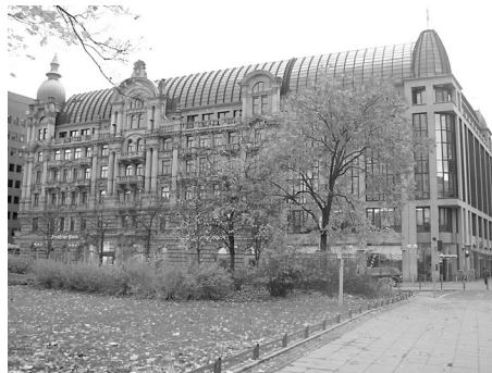
Einer der ersten Fälle von Entkernung: Ehemaliges Hotel Fürstenhof im Frankfurter Bahnhofsviertel.
