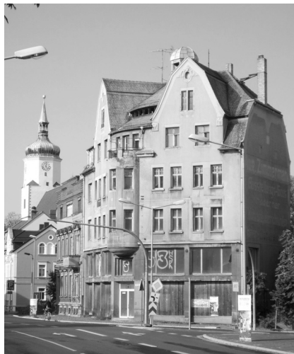
Leer stehendes Gründerzeithaus an einer Hauptverkehrsstraße in Wurzen. Foto: Gregor Jekel
