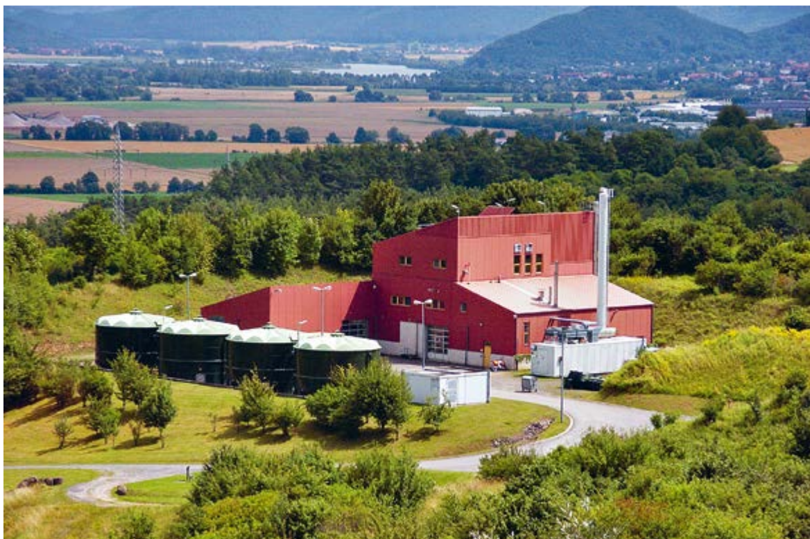
Sickerwasserkläranlage mit BHKW an der Abfalldeponie „Am Breitenberg“
