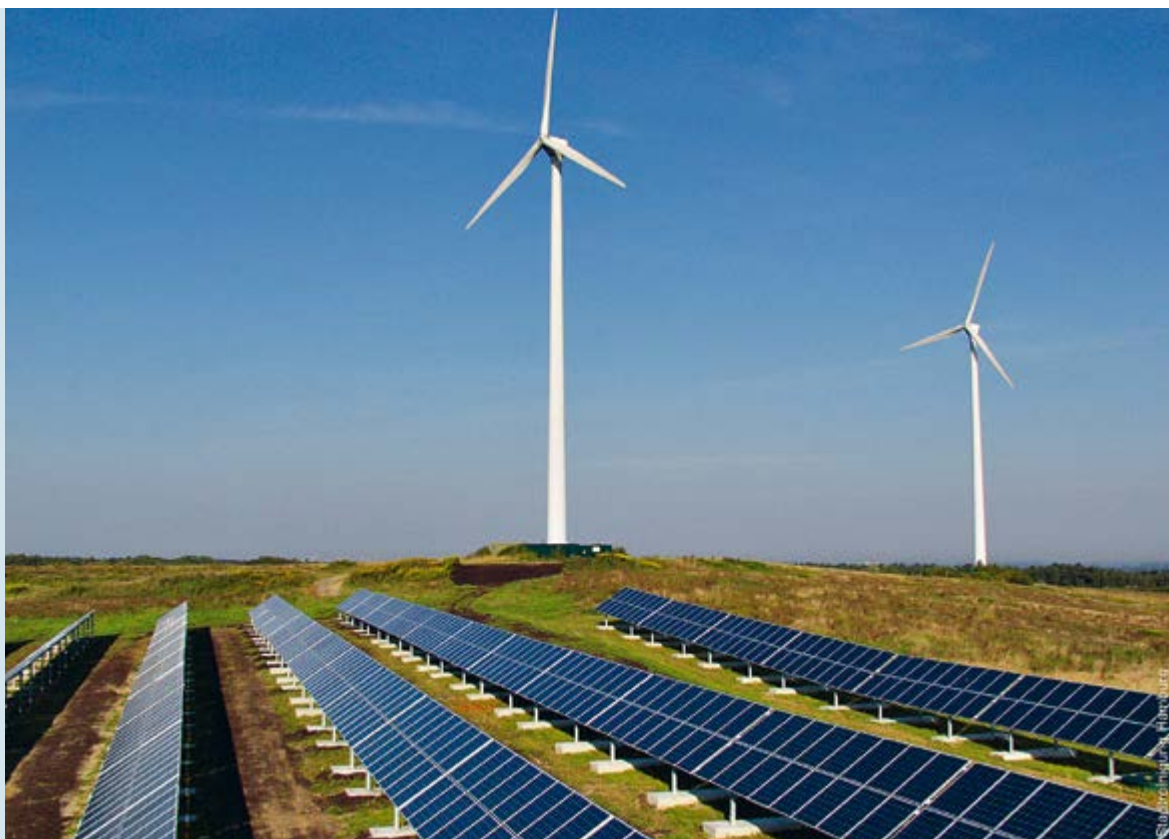
Ehemalige Deponie Neu Wulmstorf als Energieberg mit einem 300-kW-Blockheizkraftwerk für Deponiegas, drei 600-kW-Windenergieanlagen und einer Photovoltaikanlage mit 1.050 kW Leistung
