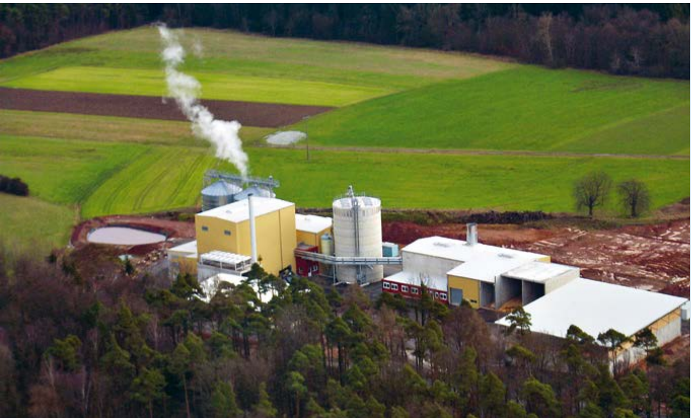
Biomasseheizkraftwerk Mudau mit angeschlossener Pelletsproduktion
