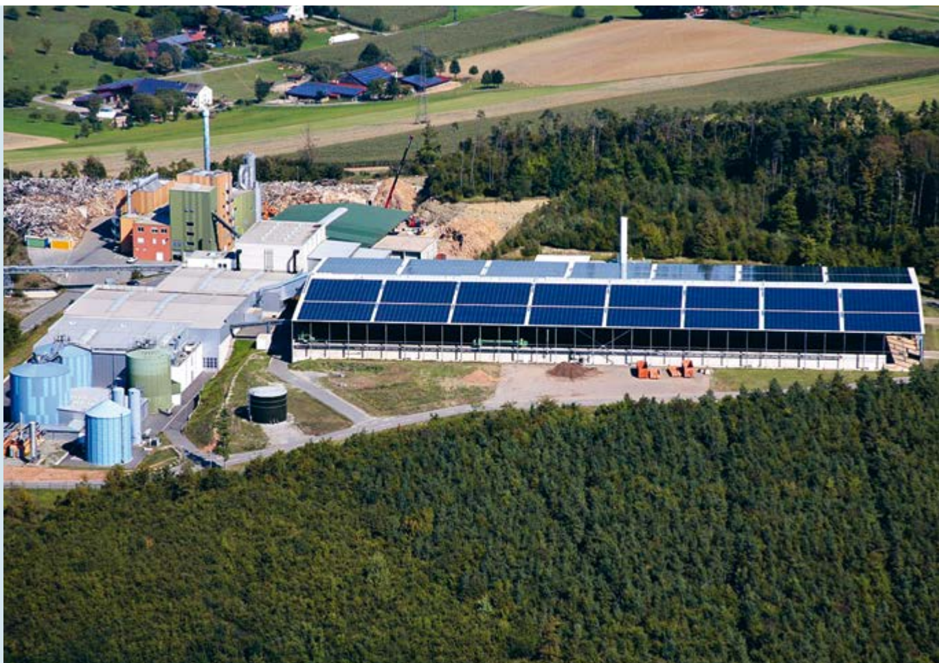
Photovoltaikanlage (1 MW) auf bestehendem Hallendach im Zentrum für Entsorgung und Umwelttechnologie Sansenhecken (Z.E.U.S.) in Buchen
