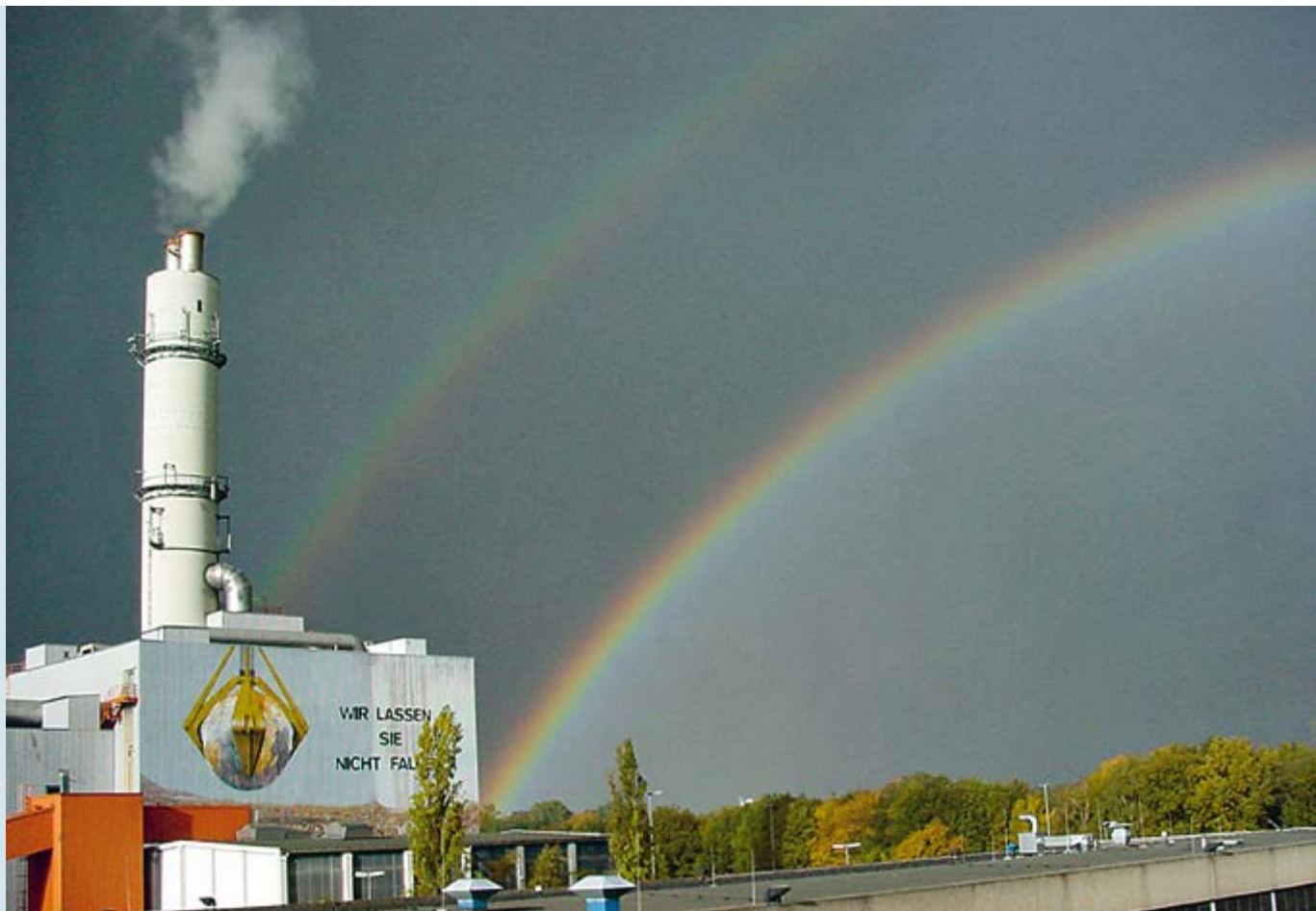
Müllverbrennungsanlage Hamburg – Stellingner Moor
