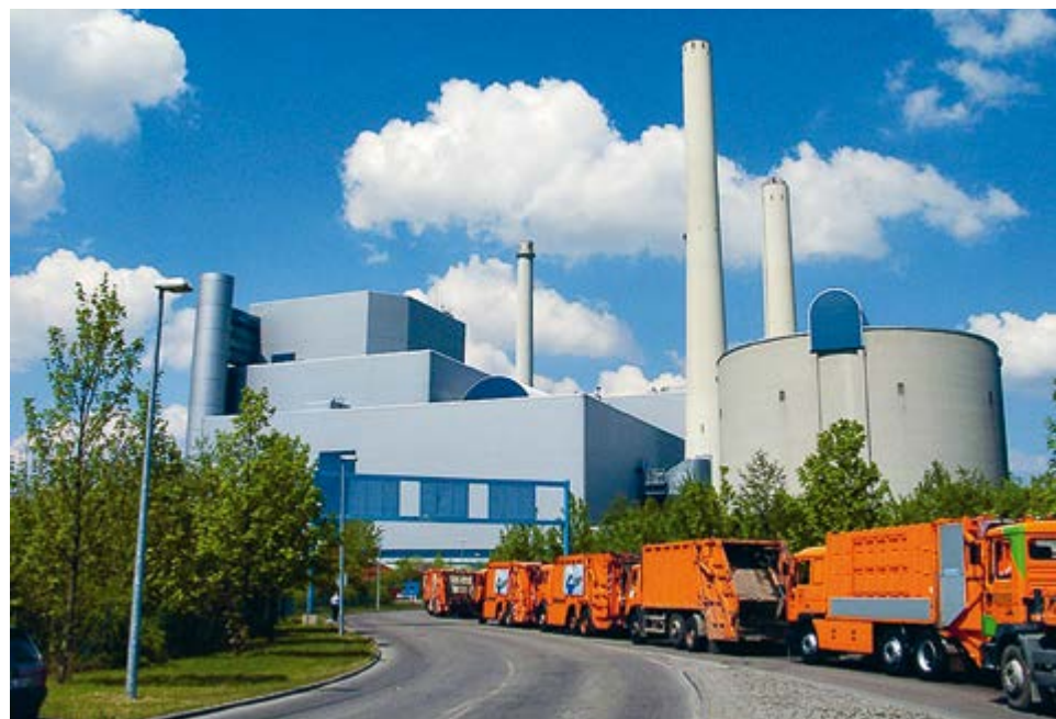
Das Münchner Müllheizkraftwerk: Stofflich nicht verwertbarer Restmüll wird zur Erzeugung von Strom und Fernwärme genutzt
