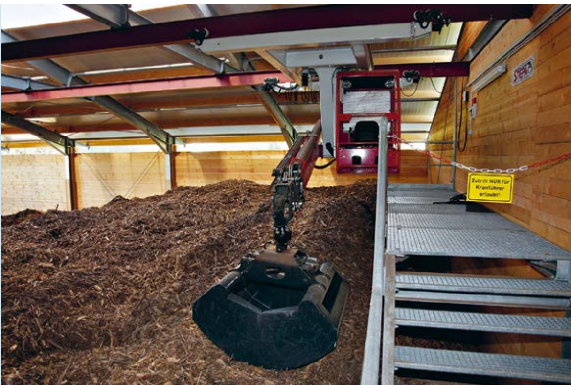
Lagerung des aufbereiteten Brennmaterials
