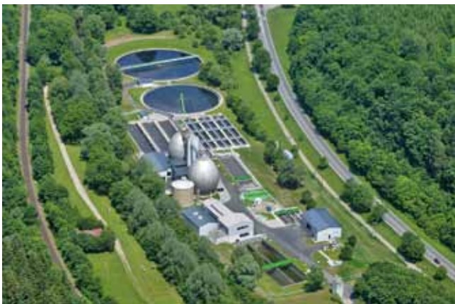
Abb. 2: Luftbild des Klärwerks Dusslingen, Foto: Abwasserverband Steinlach-Wiesaz
