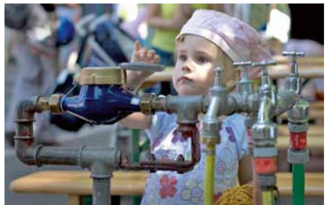
Abb. 1: NaCoSi – Steuerungsinstrumente für die Siedlungswasserwirtschaft der nächsten Generationen, Foto: Philipp Benz
