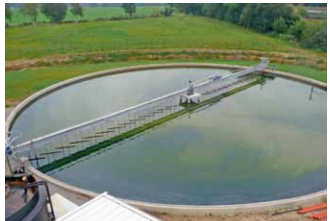
Abb. 1: Massenalgenkultur-Becken (MAK-Becken), Foto: LimnoTec
