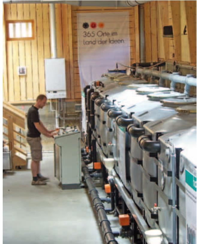
Abb. 2: Grauwasserrecyclinganlage der Wohnanlage „Block 6“ in Berlin. Foto: E. Nolde/Flickr
