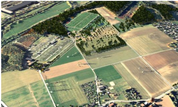
Umspannanlage Hagen-Garenfeld © Amprion GmbH
