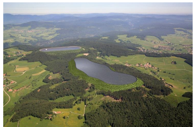
Hornbergbecken II / Oberbecken © Schluchseewerk AG
