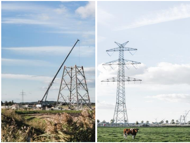
Westküstenleitung Mastbau 380 kV © TenneT TSO
