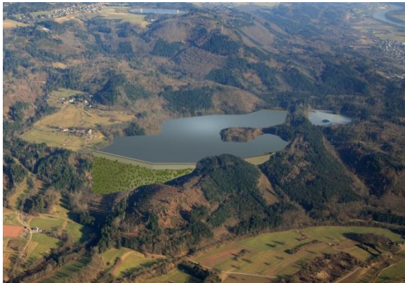
Haselbecken/Unterbecken © Schluchseewerk AG
