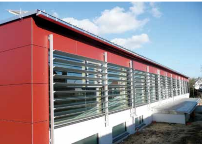
Außenansicht mit Verschattungslamellen
