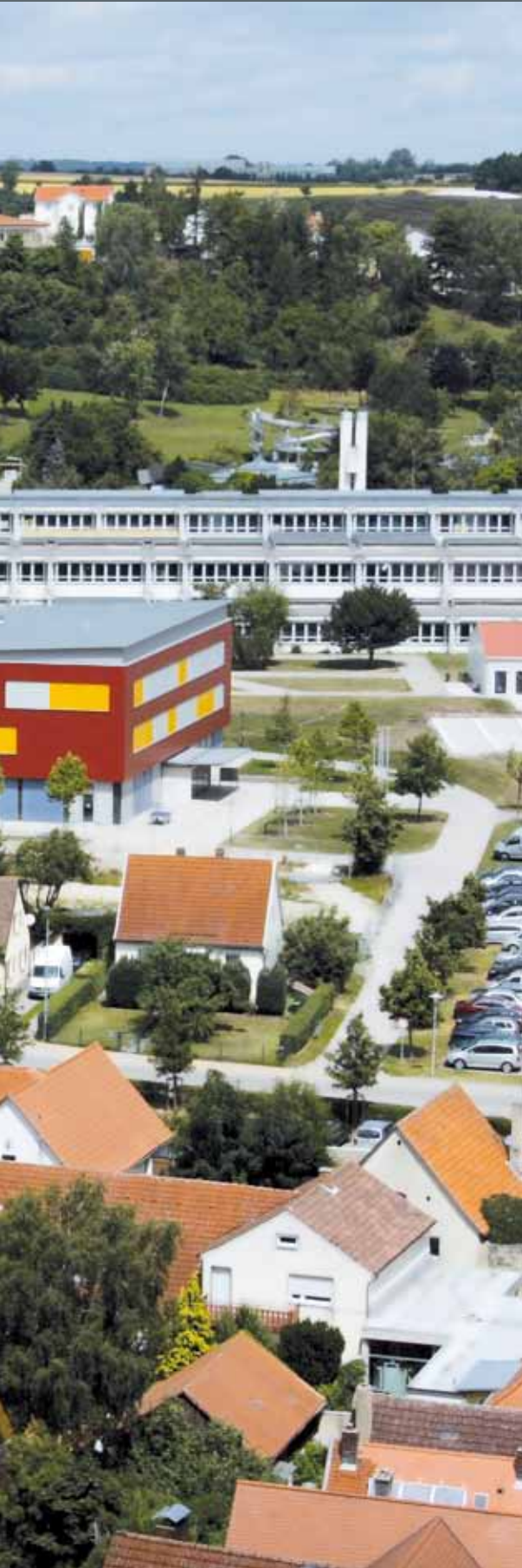
Luftaufnahme der Dreifachsporthalle Herrieden mit Photovoltaikanlage
