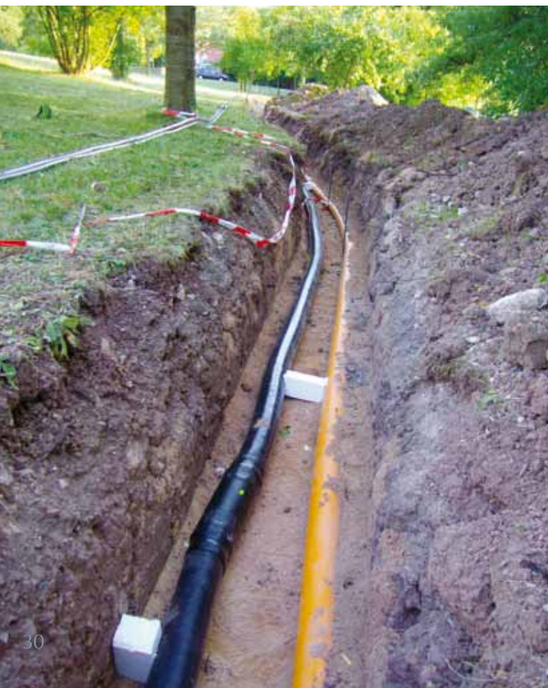
Erdverlegte Biogasleitung
