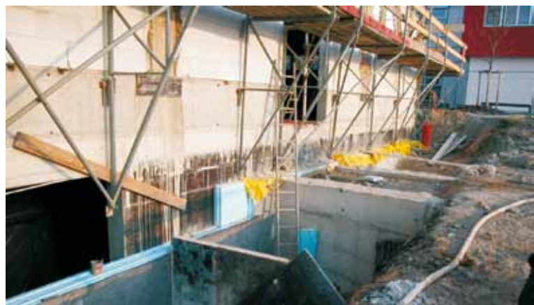
Baumaßnahmen zur Wärmebrückenvermeidung
