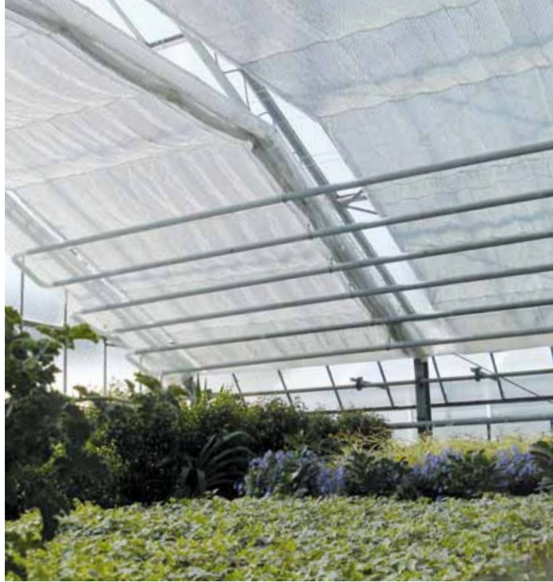
Ausgefahrener Energieschirm gegen zu intensive Sonneneinstrahlung
