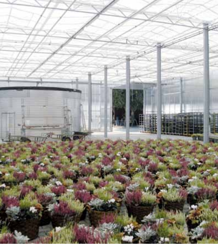
Regenwasserauffangananlage als Bewässerungssystem
