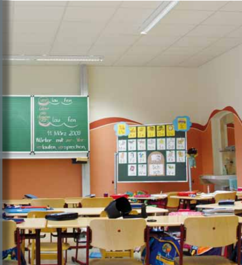
Ausgewogene Beleuchtung im Klassenzimmer
