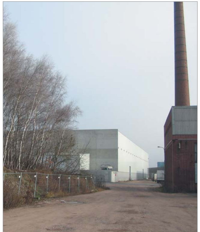
Die Altablagerung der ehemaligen Asbestzementproduktion soll für neue Logistikansiedlungen nachgenutzt werden.
