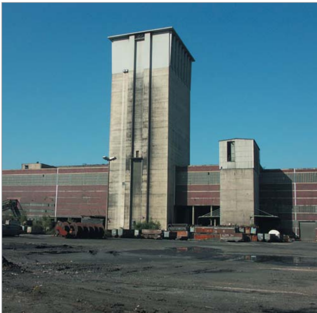
Blick auf den imposanten Förderturm mit Wagonumlauf der Zeche Westerholt
