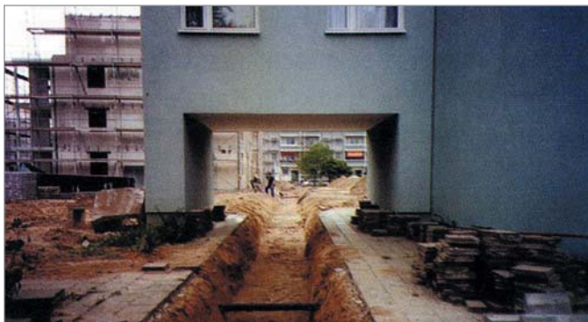
Umbau technischer Infrastruktur im Stadtbau
