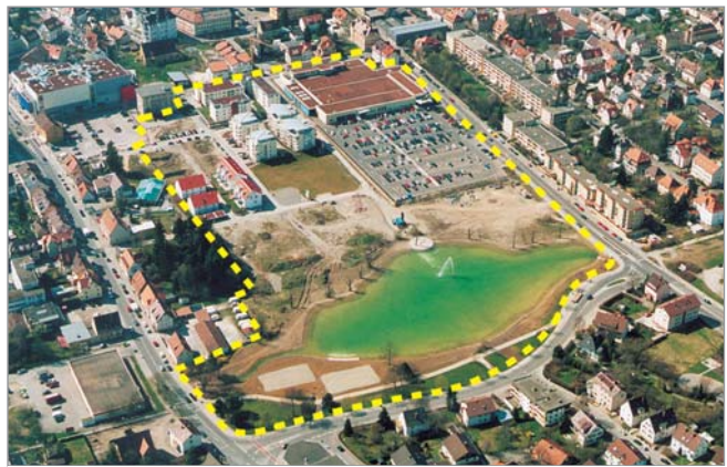
Ehemalige Uhrenfabrik Kienzle (Villingen-Schwenningen): Fünf Hektar hoch kontaminierter innerstädtischer Brachfläche wurden durch die Unternehmensgruppe Dr. Eisele entwickelt. Möglich wurde dies durch die Integration von Sanierungsplanung und städtebaulicher Entwicklung.
