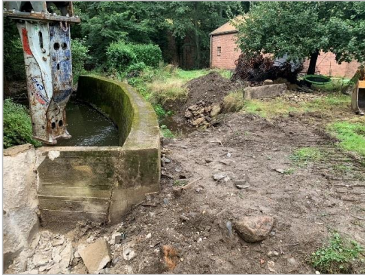
Abb. 26: Ufermauer vor der Umwandlung
