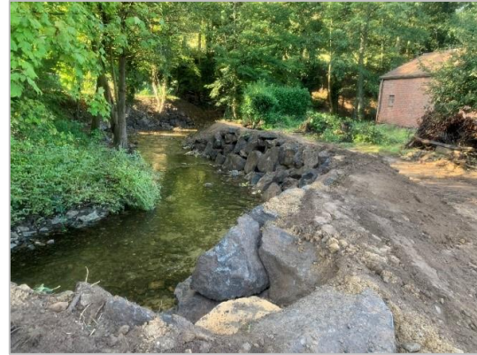
Abb. 27: Böschung nach der Umwandlung
