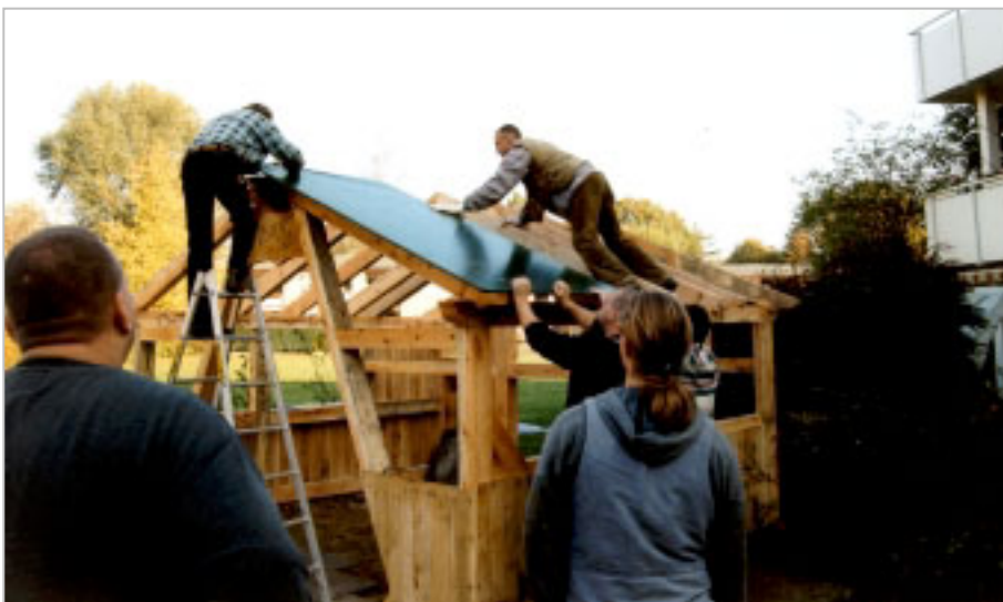
Foto 2: Bau einer Hütte am Spielplatz
