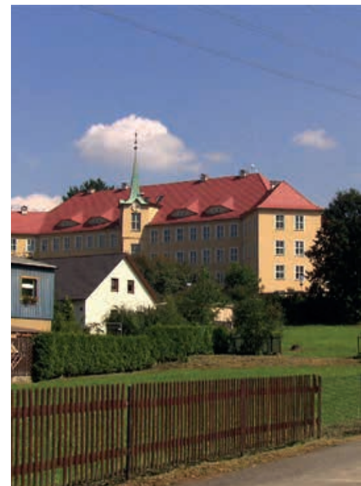
Denkmalgeschützter Schulkomplex, Olbersdorf bei Zittau
