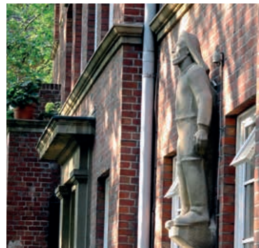
Hamburg: Historisches Wohngebäude der Allgemeinen Deutschen Schiffszimmerergenosenschaft mit Backsteinfassade
