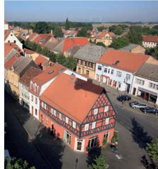
Historischer Stadtkern in Treuenbrietzen Foto: Jürgen Hohmuth/zeitort.de
