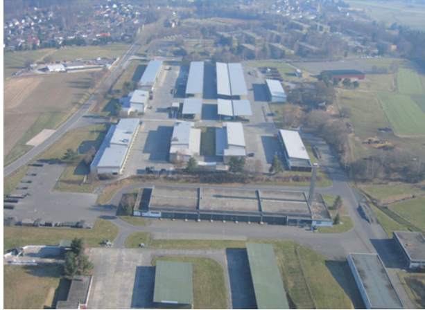
Foto 12: Blick auf den ehemaligen Technikbereich, im Hintergrund der Unterkunftsbereich; Stadt Neustadt (Hessen)
