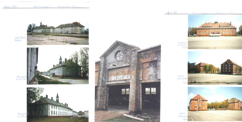
Abb. 18: Auszug Fotodokumentation denkmalgeschützte Gebäude; Landeshauptstadt Schwerin, Amt für Stadtentwicklung
