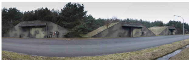
Foto 18: Aufgeschüttete Bunker im Zentrum der Konversionsfläche; Ulrich Gunka
