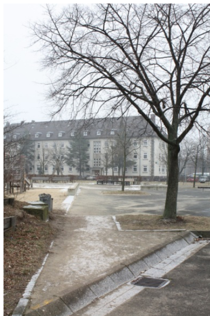
Foto 11: Entsiegelung des Exerzierplatzes im Prinz-Albrecht-Carré als externe Ersatzmaßnahme; Difu
