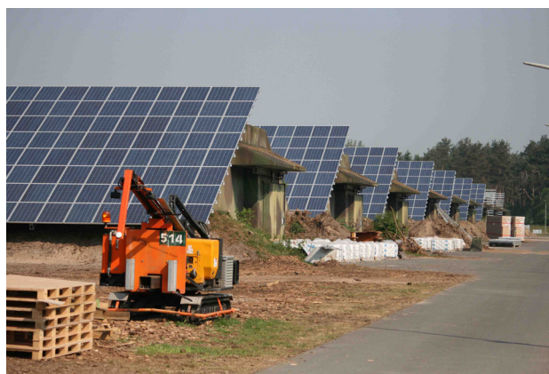
Foto 20: Errichtung von Photovoltaikanlagen auf den Bunkern; Marlies Grüter
