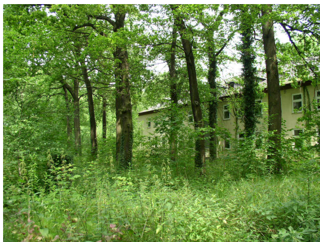
Foto 1: Kasernengelände und Vegetationsbestand vor der Sanierung; Stadt Dortmund
