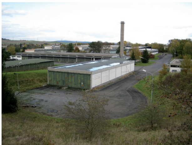
Foto 13: Blick auf den ehemaligen Technikbereich, im Hintergrund der Unterkunftsbereich; PW.U – Planwerk.Umwelt, Berlin
