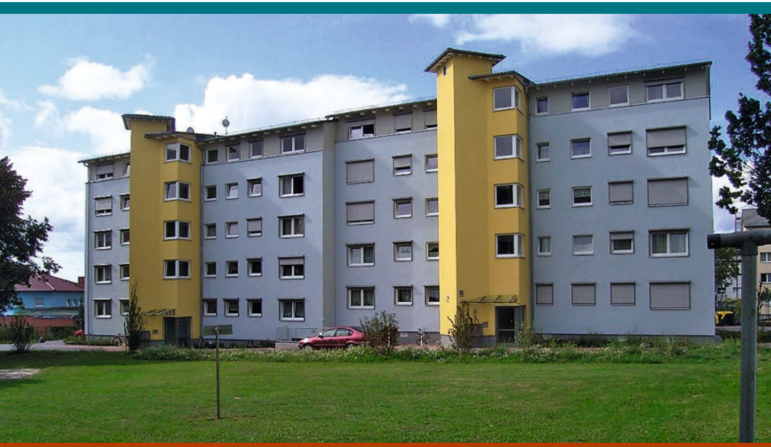
Außenansicht nach der Sanierung
