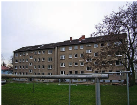
Außenansicht vor der Sanierung
