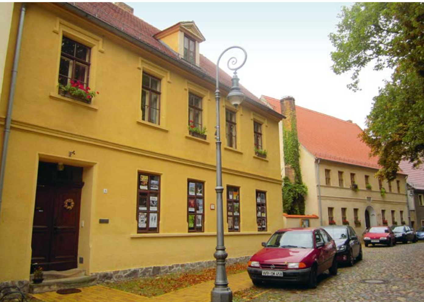
Bad Schmiedeberg – Gemeindehäuser
