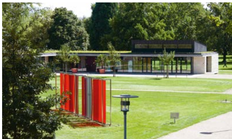
Oben: Die Heizentrale im Quartier Kreuzschlag aus den 1990er-Jahren versorgt 1.200 Wohneinheiten mit Wärme aus Kraft-Wärme-Kopplung – unten: Das Stadtteil- und Familienzentrum Innenstadt wird über oberflächennahe Geothermie-Potenziale geheizt
