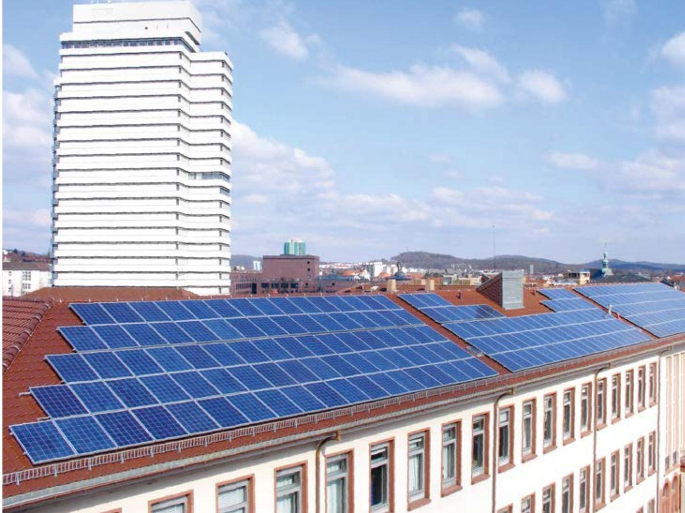
Solaranlage Burggymnasium Kaiserslautern
