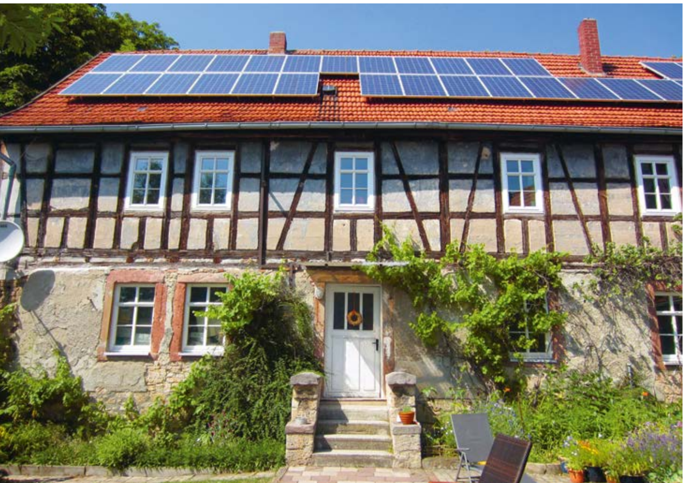
Photovoltaik-Anlage vor klimaschutzrelevanter Sanierung des Evangelischen Pfarrhauses Etzleben
