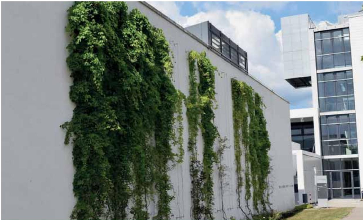
Abb. 63: Bodengebundene Fassadenbegrünung
