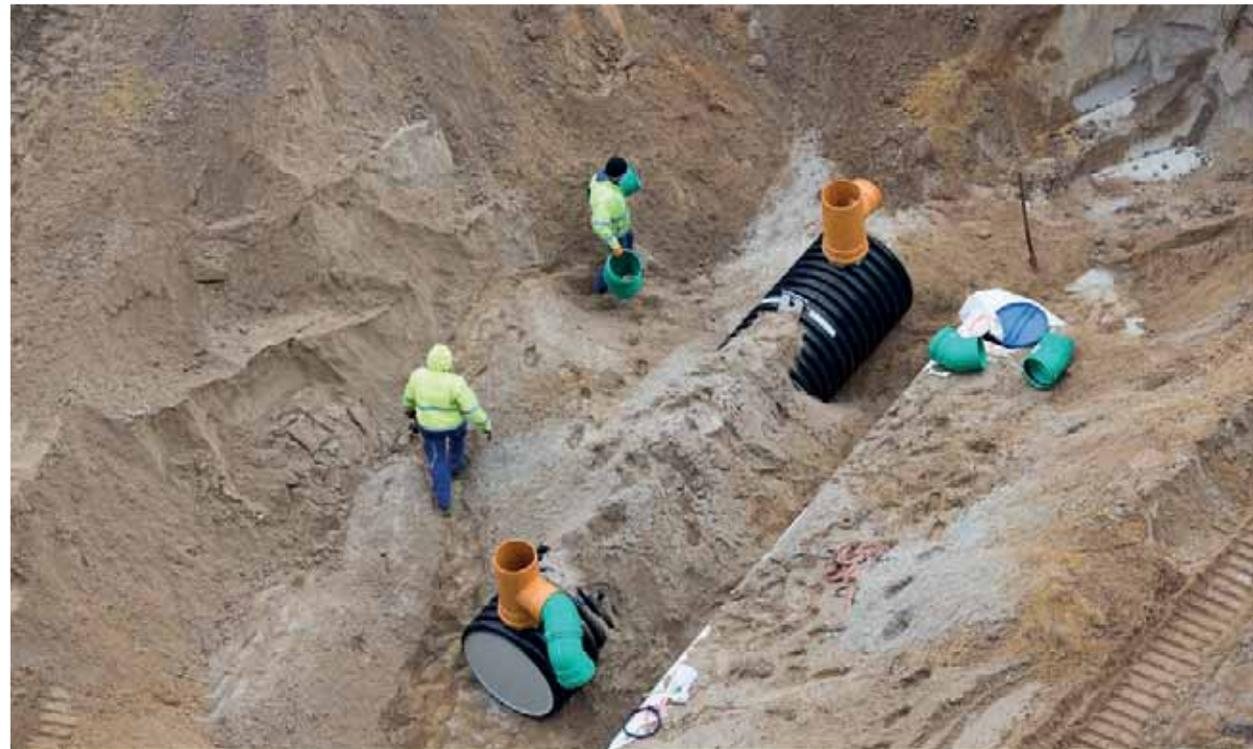
Abb. 66: Anschluss einer Rigole zur Regenwasserversickerung.
