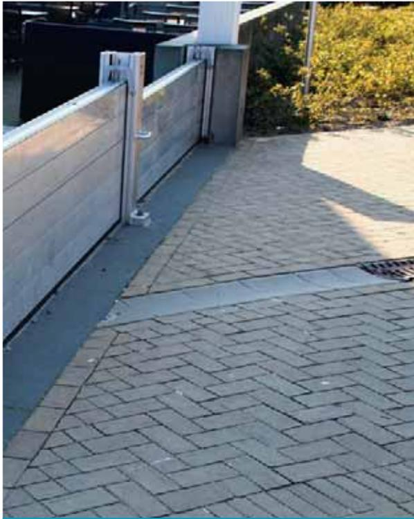
Abb. 53: mobile Flutmauer;
