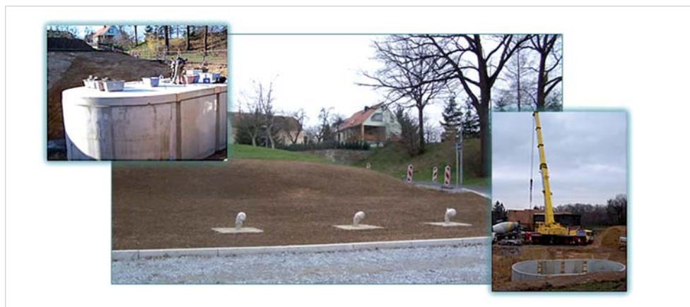
Abbildung 3: unterirdischer Löschwasserbehälter - ULB ( www.landschaftsplaner.eu )
