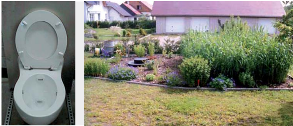
Abbildung 6: Vakuumtoilette (links) und Bodenfilter (rechts) ( www.flintenbreite.de , www.zebrafilter.de )
