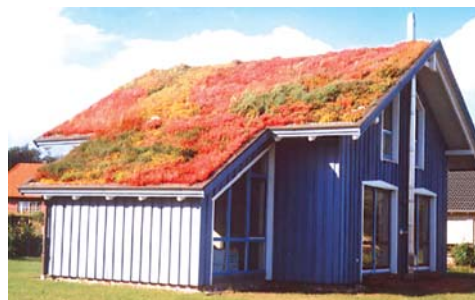
Abbildung 5: Gründächer (extensive Nutzung) als Flach- und Schrägdächer
