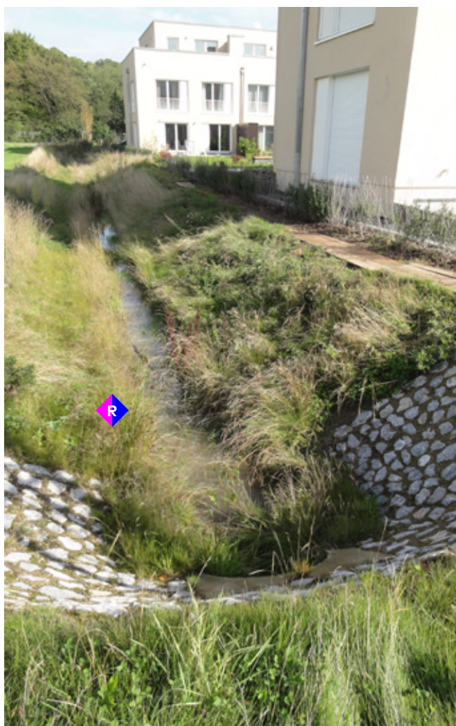
Offene Ableitung von Niederschlägen im Quartier
