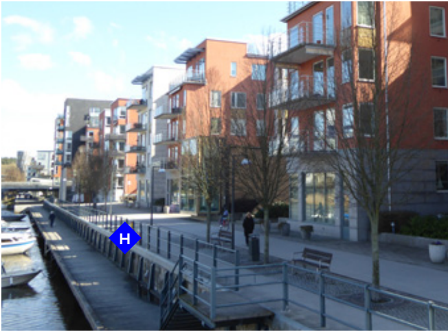
Wasser macht sommerliche Hitze erträglicher, erfordert aber auch wirksamen Überflutungsschutz.
