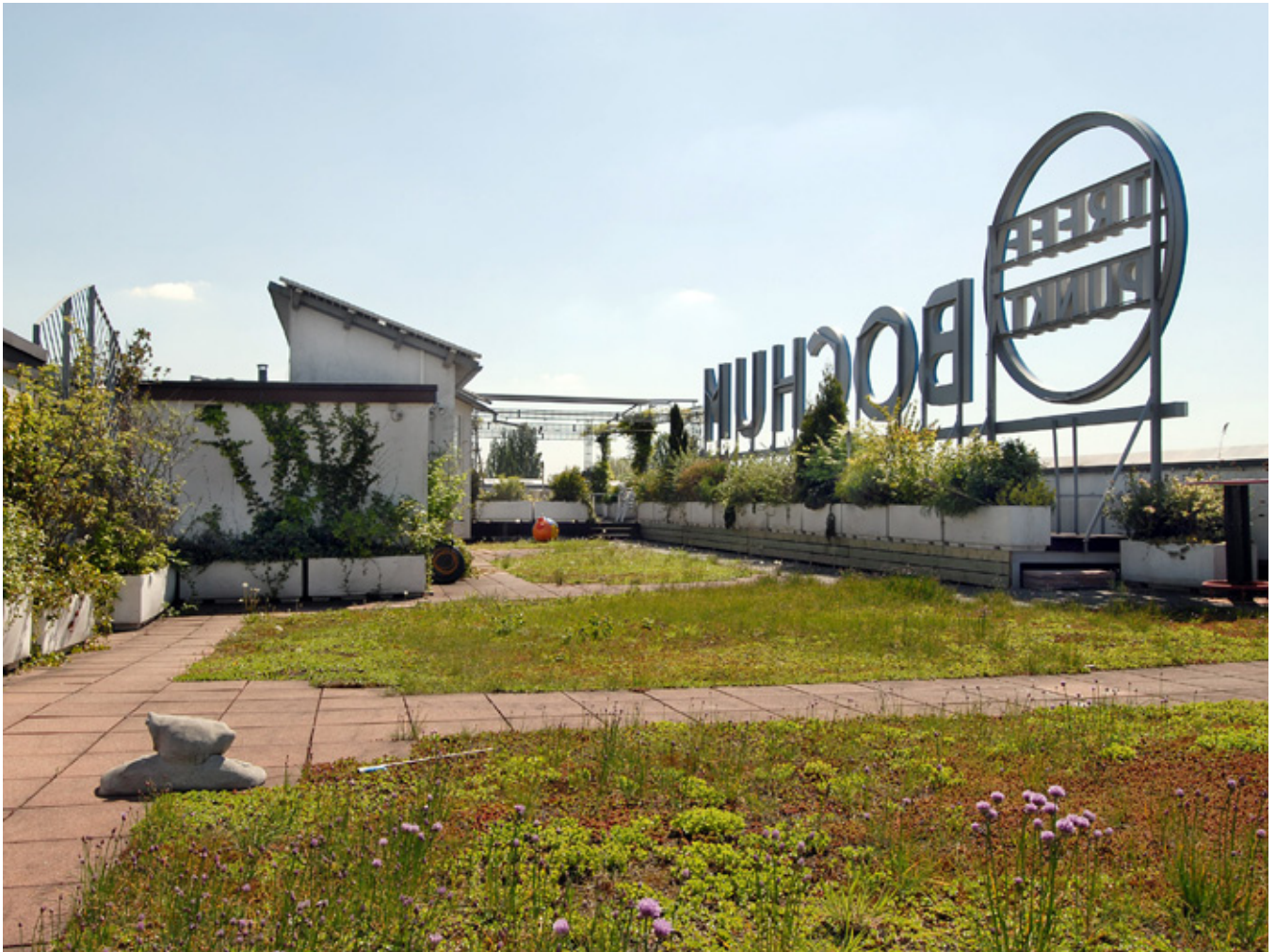
Dachgrün, Retentionsflächen und Fassadengrün
