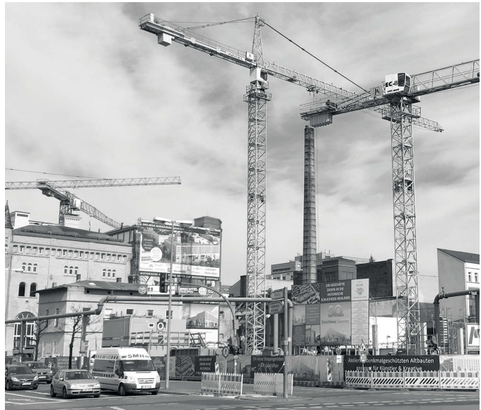
Abbildung 1: Baustelle für das neue „Schultheiss-Quartier“ (Foto: C. Hoja 2017)
