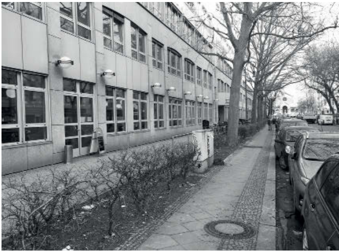
Abbildung 6: Gehwegbereich vor der Kirchstraße 6–7 (Foto: C. Hoja 2017)
