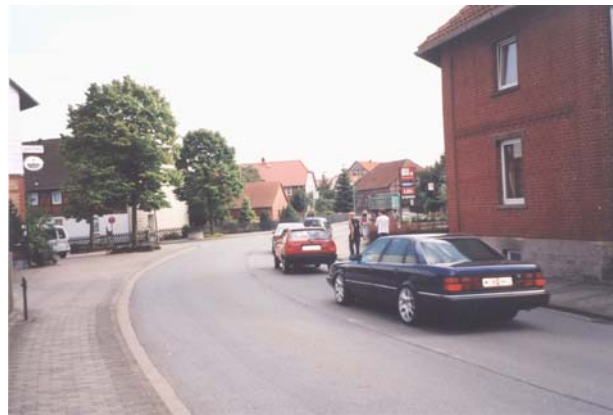
Bild 4-8: Fehlende Querungsmöglichkeit im Bereich einer Ortsdurchfahrt (Wolfsburg)
