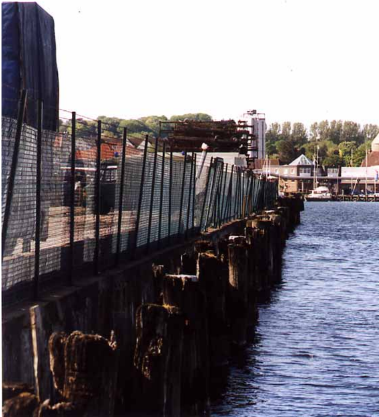
Uferkante hinter den Fahrzeugwerken (links) und Firma Hinrichs, geplanter Zugang zur Förde
