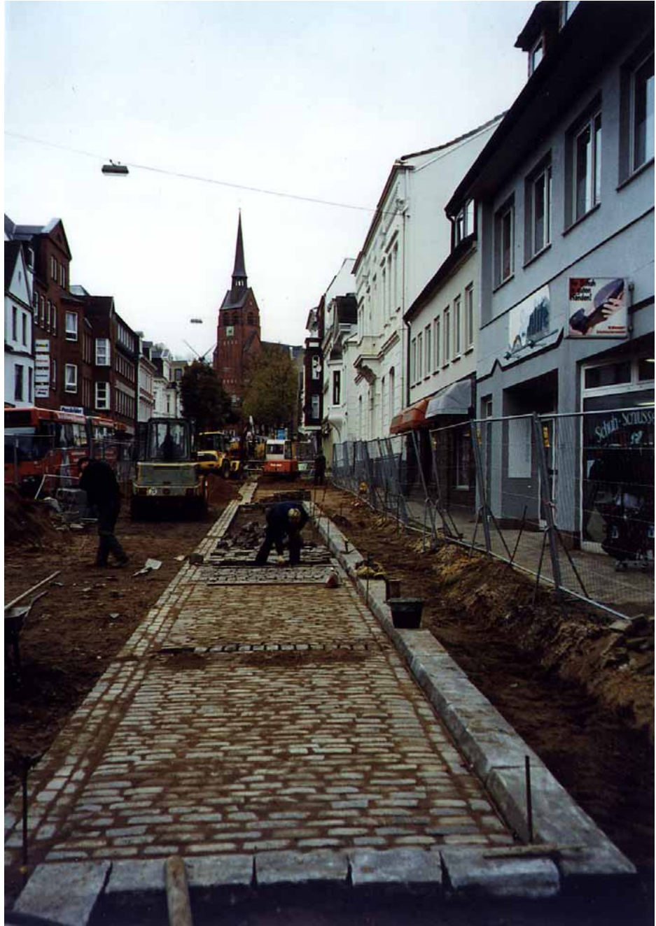
Die Straße Neustadt im Bau, Anfang 2002
