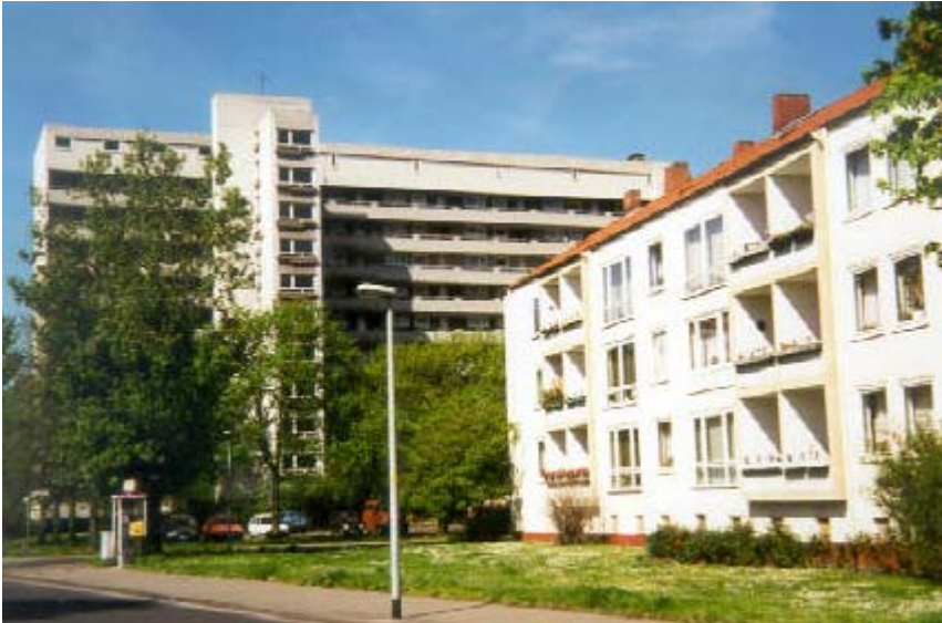
Foto 19 Scheibenhochhaus und typische Zeilenbauten im Quartier 1207
