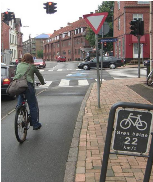
Abbildung 20: Ankiündigung der Grünen Welle mit Angabe der Progressionsgeschwindigkeit in Odense (Tom Bertulis)
