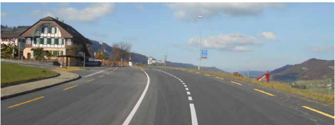
Abb. 4: Blick Fahrtrichtung Bern, Nachher-Situation (Foto TBA Kanton Bern)
