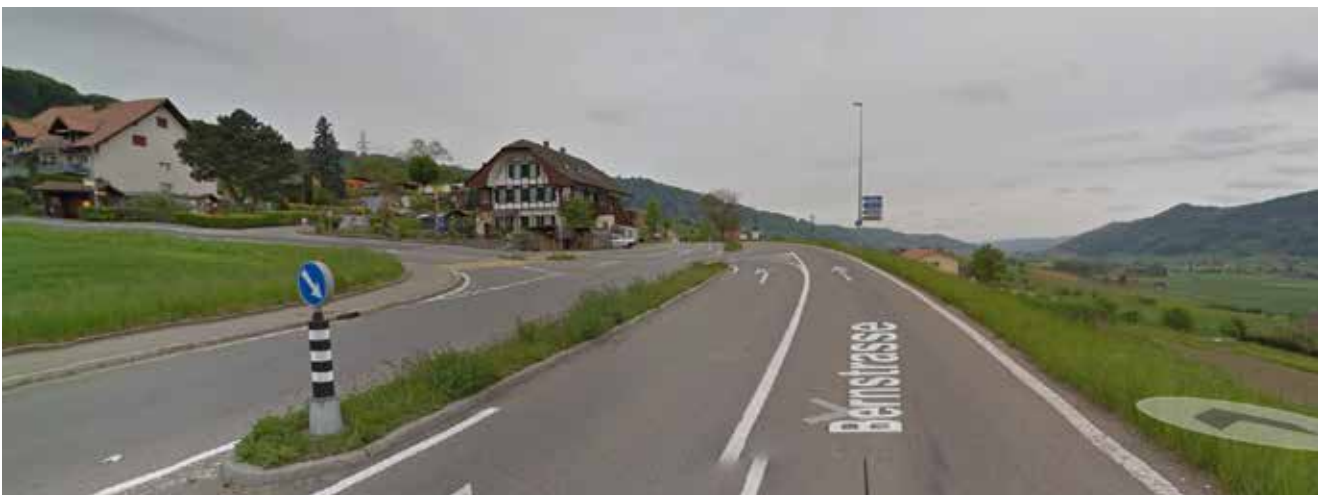
Abb. 2: Blick Fahrtrichtung Bern, Vorher-Situation (Quelle: Google Street View)
