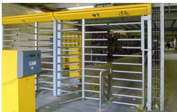
Drehkreuzanlage in Karlsruhe
