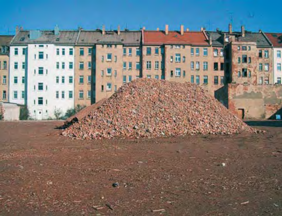
Brachfläche, Modernisierungs- und Sanierungsmängel Bildquelle: Büro Kaufmann, Leipzig
