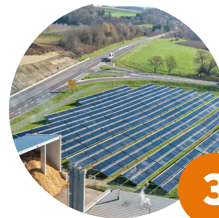
Solarthermieanlage in Überlingen-Schättlisberg
