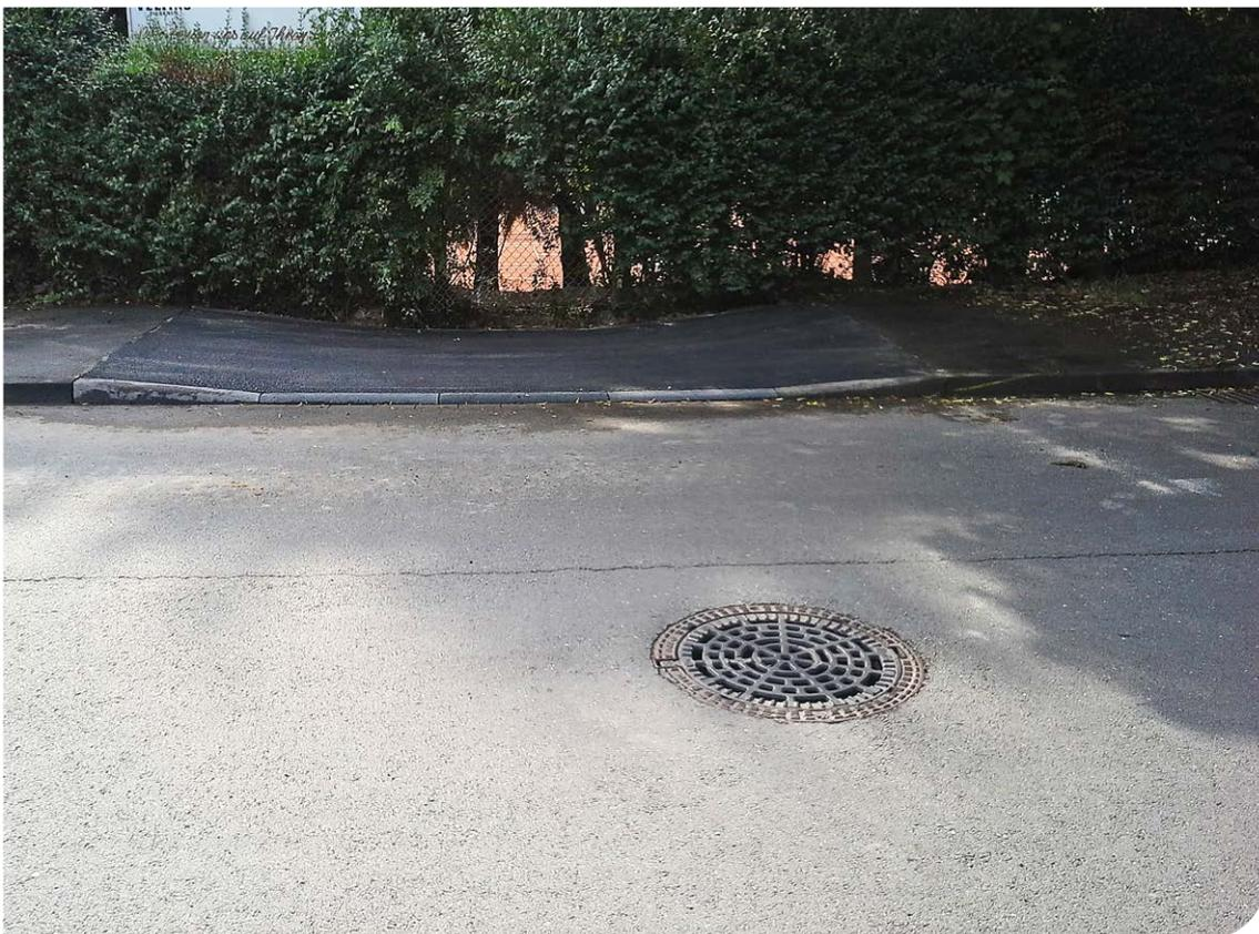
In Solingen wird Wasser in einem Tiefpunkt vom Straßenbereich durch geöffnete Schachtdeckel dem Kanal zugeführt und bei Überlastung über einen abgesenkten Bordstein von der Straße weggeführt.
