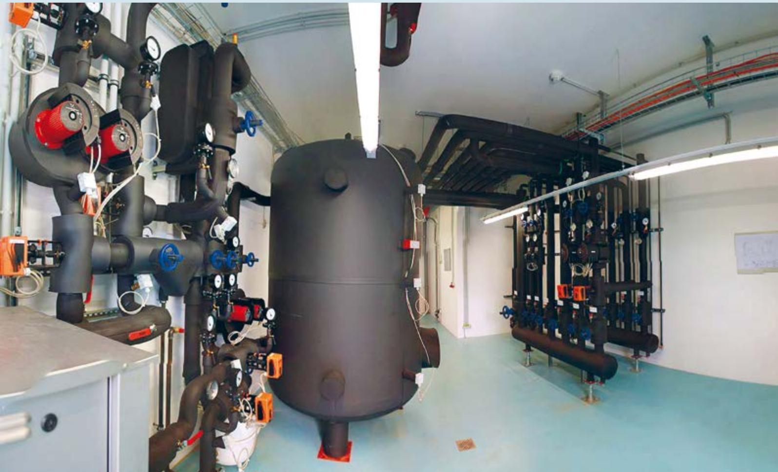
Kühlwasserkreislauf (links Verzweigung Chiller/Wärmetauscher, Mitte Pufferspeicher, rechts Verteilung zu Verbrauchern)
