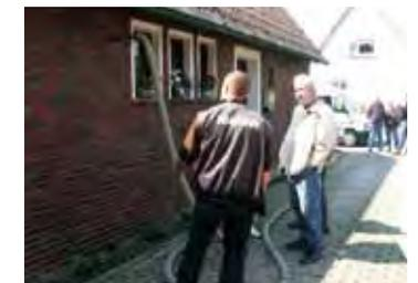
Einblasdämmung in die Hohlschicht des Mauerwerks
